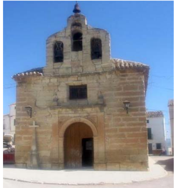
Fachada de la iglesia de Cárcchel
